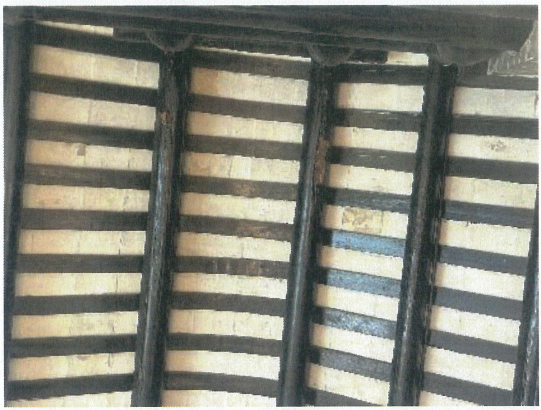
屋面风化，梁架、檩条等木构件局部风化开裂，糟朽
