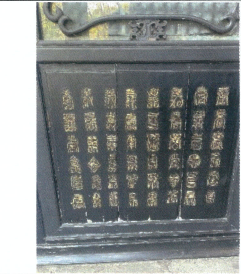
碧溪草堂百寿图局部风化开裂褪色
