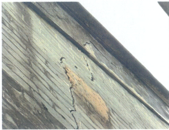
屋面风化，梁架、檩条等木构件局部风化开裂，糟朽
